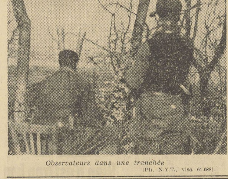
Observateurs dans une tranchée (Ph. N.Y.T., visa 61.088).
