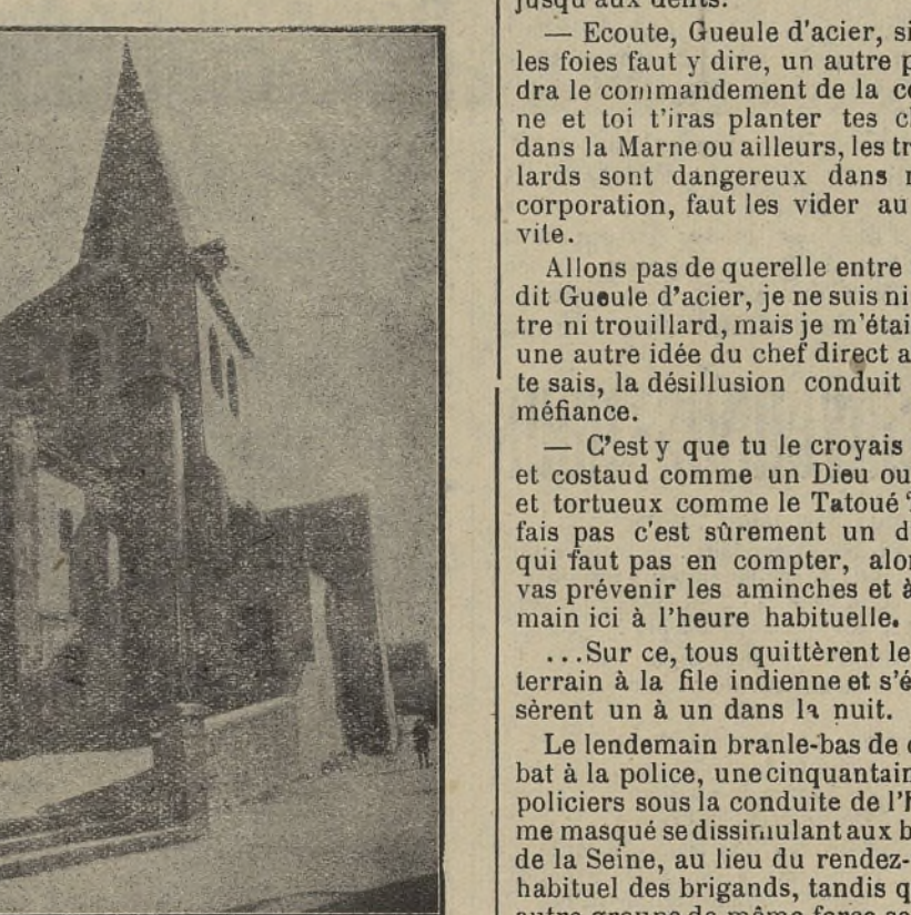
Eglise Saint-Aré à Decize
