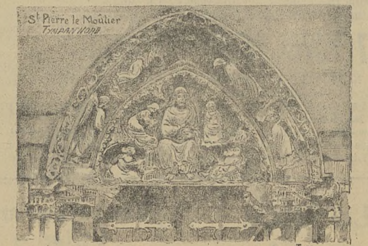
Détail d'architecture de l'Eglise de Saint-Pierre
