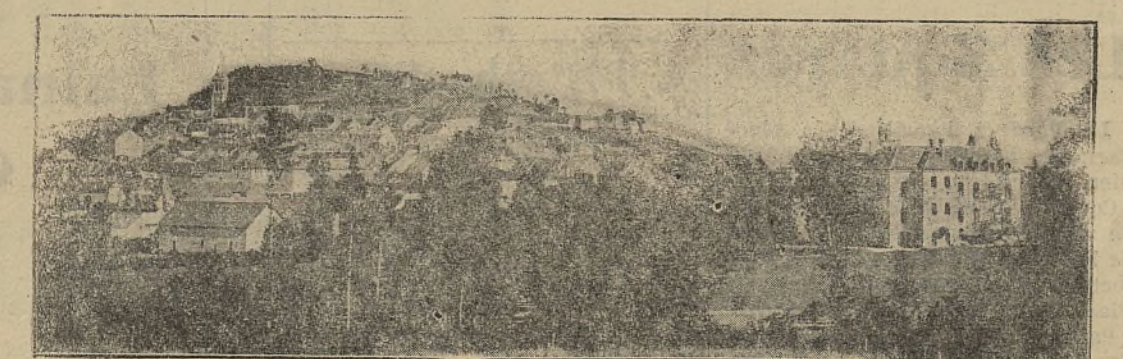
Vue Générale de Château-Chinon
