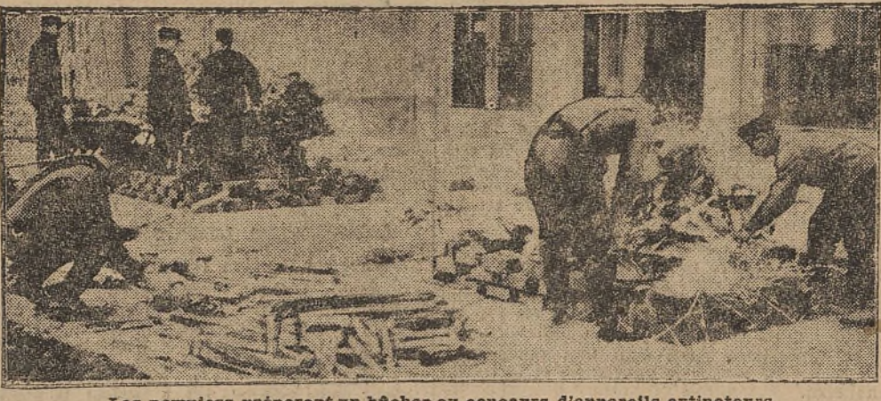
Les pompiers préparant un bâcher au concours d'appareils extincteurs
