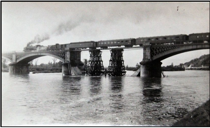
Ci-contre, article du journal Paris-Centre du 6 octobre 1940 Ci-dessus, le pont provisoirement réparé.
